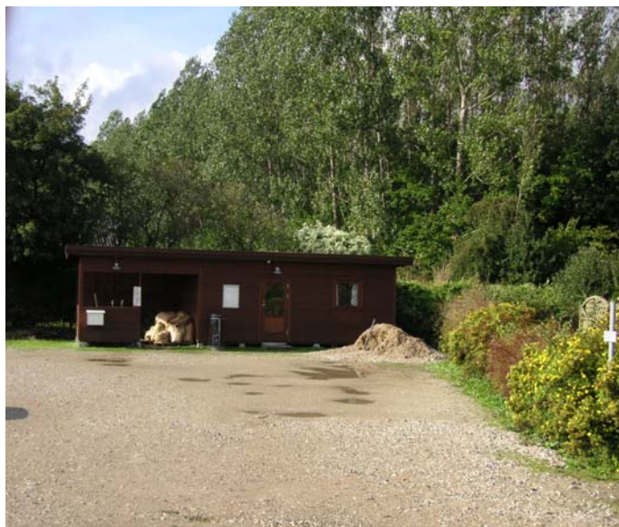
Det eksisterende fælleshus på ca. 55 m 2 i Haveforeningen Kettehøj.
